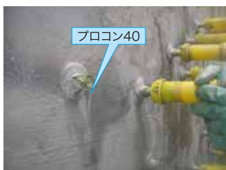
プロコン40先行注入の状況
