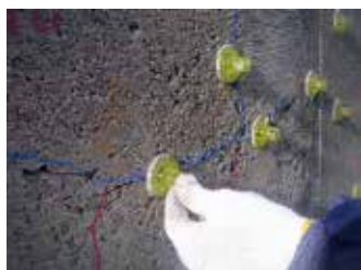
座金設置状況
