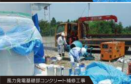
風力発電基礎部コンクリート補修工事
