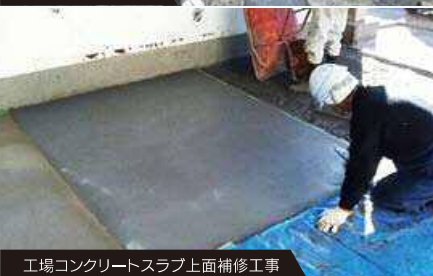
工場コンクリートスラブ上面補修工事
