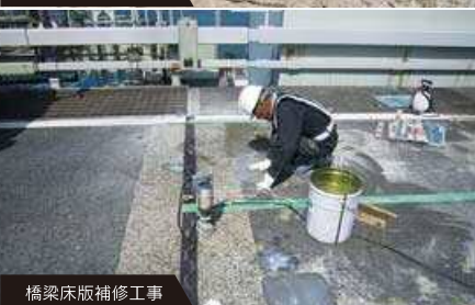
橋梁床版補修工事
