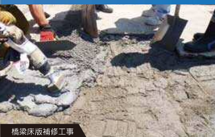
橋梁床版補修工事
