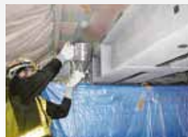
ゴムラテコーティング吹き付け
