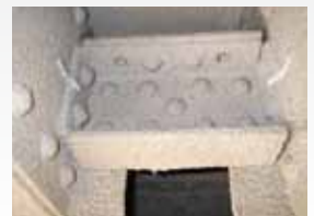
ゴムラテコーティング吹き付け完了
