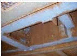
クレン作業 (バキュームプラスト) 前
