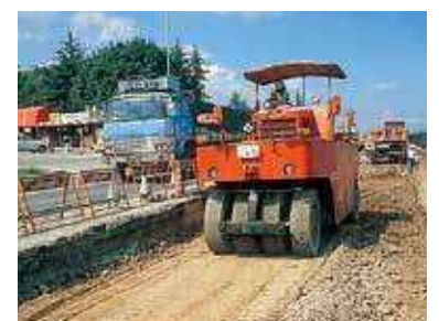
改良手順5 (転圧)
