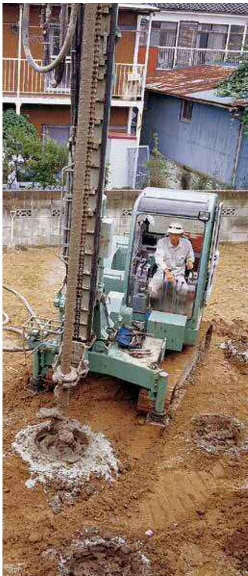
ソイルセメントコラム工法
