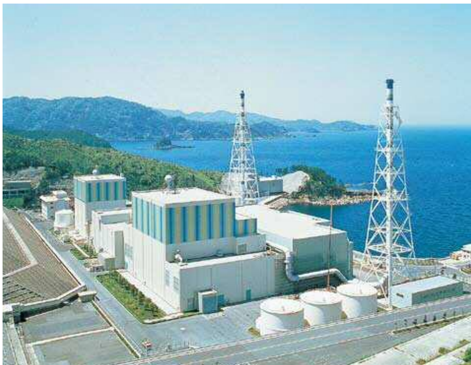
島根原子力発電所
