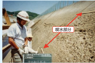
補修前の劣化状況
